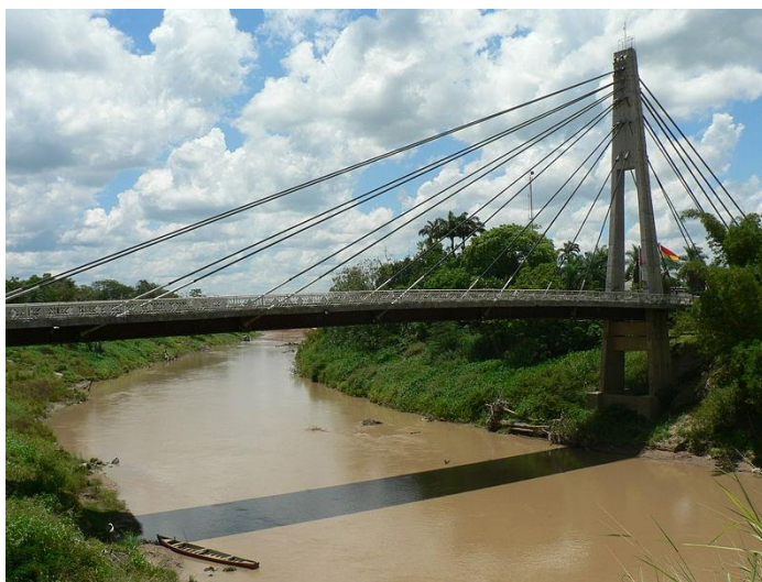
Figura 2. Ponte Binacional Wilson Pinheiro
