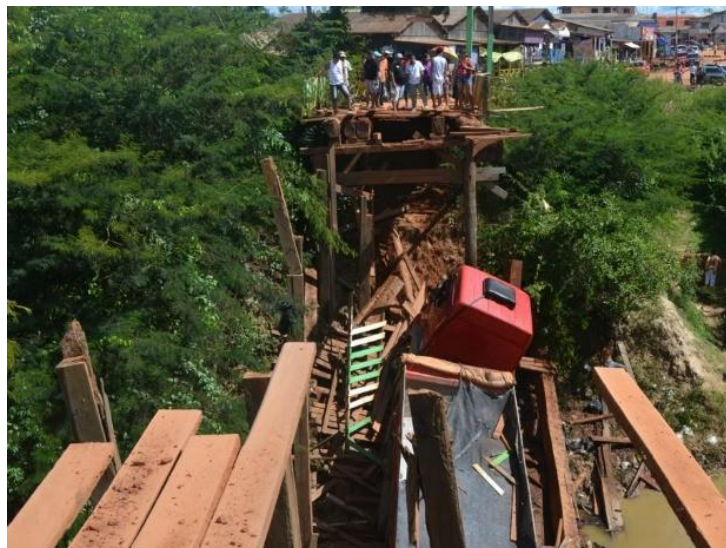
Figura 3 – Ponte sobre o Igarapé Rapirrã
